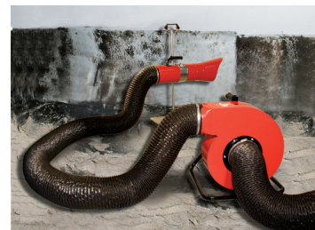
Wentylator przenośny osuszający zawilgoconą ścianę
