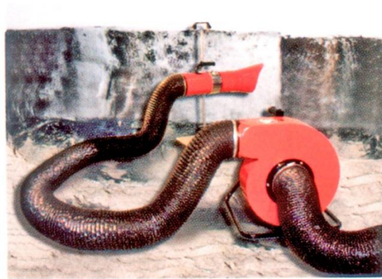
Wentylator przenośny osuszający zawilgoconą ścianę
